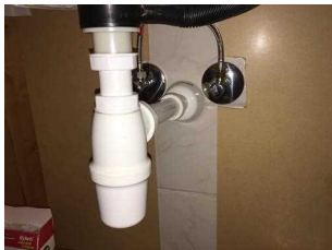
Vann- og avløpsrør under servant på vaskerom
