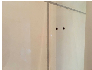
Hull i fliser i våtsone.
